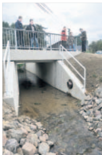
Die neue Brücke über den Kalten Bach. Foto: Dirk Zschiedrich
